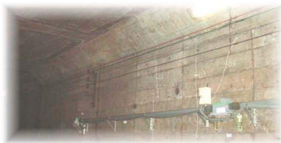
設置箇所・地下鉄トンネル
