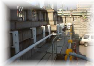
設置箇所・橋梁
