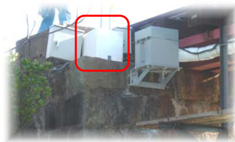
設置箇所・鉄道橋梁橋台
